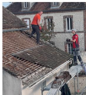
Réfection de la toiture du local technique de l'école à la suite de la rupture d'une partie des liteaux sur le côté gauche. Cette rupture pouvant entraîner des fuites et donc des réparations plus
