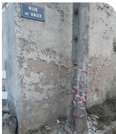
Le poteau béton situé à l'angle de la rue de Vaux a été partiellement détruit par un véhicule non identifié. Malgré le choc important, la structure métallique n'a subi que quelques déformations.
