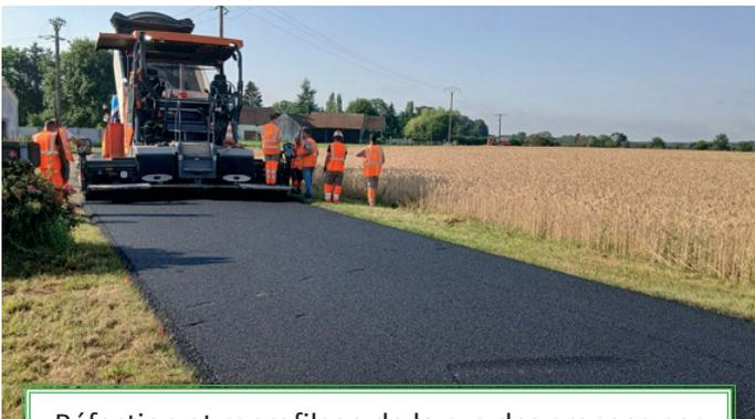
Réfection et reprofilage de la rue des granges par la pose d'un nouvel enrobé à l'entrée du village.
