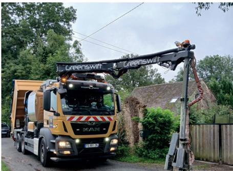
Remise en état des routes, le C11, la rue du puit du village, la rue des granges. Un engin ultra moderne capable de reboucher rapidement et efficacement les petits affaissements et trous dans la chaussée. Pendant trois jours, ce véhicule procède au rebouchage par la technique de l'enrobé projeté.
